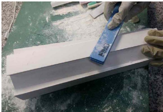
[도 31] 사포를 이용한 연마작업
